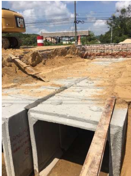
รูปที่ 5.3-2 ตัวอย่างการปรับปรุงอาคารระบายน้ำผ่านถนน โดยใช้งบประมาณกลางพายุเชินกา พ.ศ. 2560 (ทางหลวงหมายเลข 408 ตอนทุ่งหวัง - นาที บริเวณ กม.182+261 ถึง กม.190+411)
